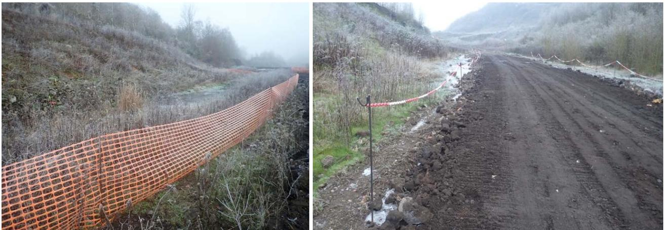
*Exemple de balisage perméable temporaire sur un chantier*
